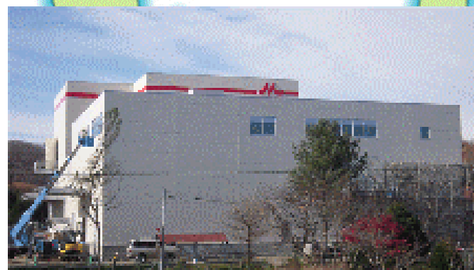
現在工事中の浦幌乳業増設棟
